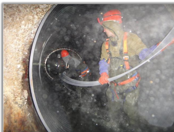
Схема формирования трубы в существующем коллекторе Ду1900 мм
